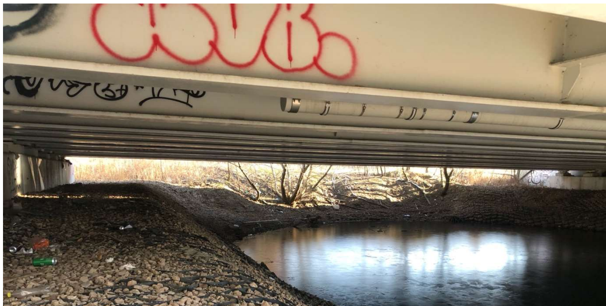
Fotografia 37 Most pod ulicą Wirążową
