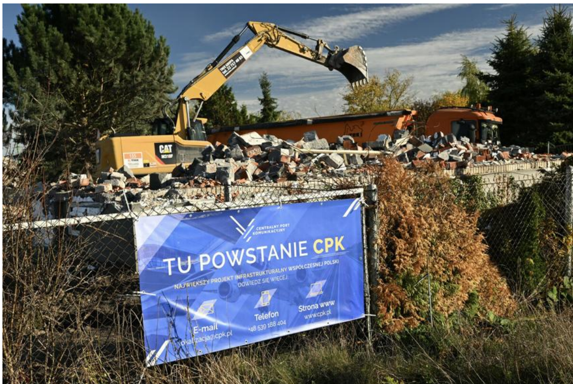
Rys. 8. Rozbiórka budynków pod CPK. | Foto: Oleg Marusic/REPORTER / East News
